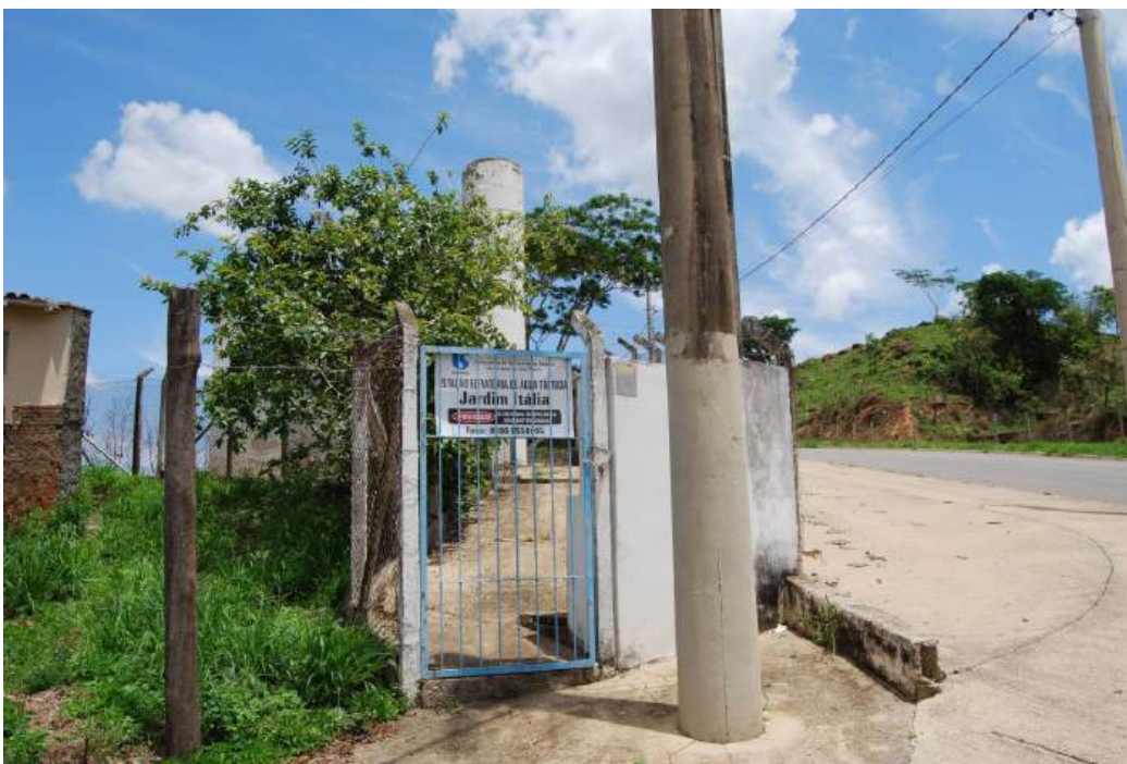
Foto 10 – Área de Influência Imediata – All – Vista da Estação Elevatória de Água Tratada. As áreas de entorno são bem servidas por infraestrutura urbana. Fonte. Flektor Urbanismo.
