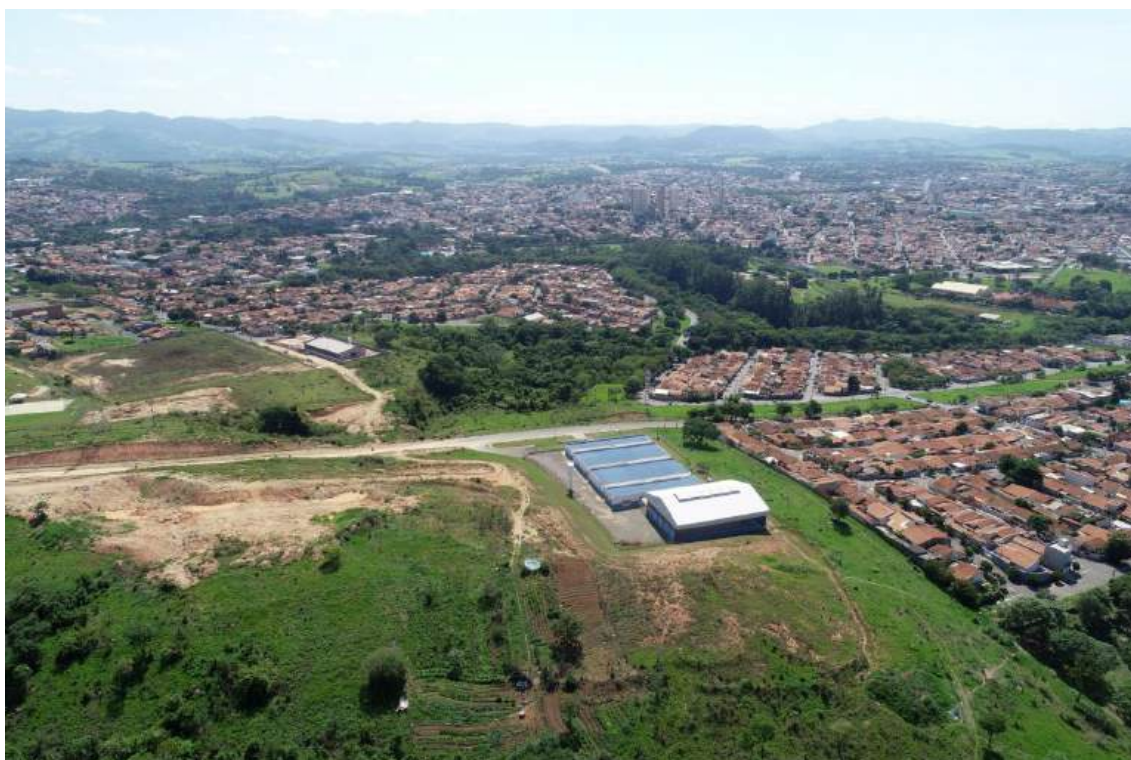
Foto 18 - Vista da área do empreendimento, demonstrando o prolongamento da Avenida Adolfo Domingues e a EMEB João Baptista Scannapieco. Tag Geo Engenharia.
