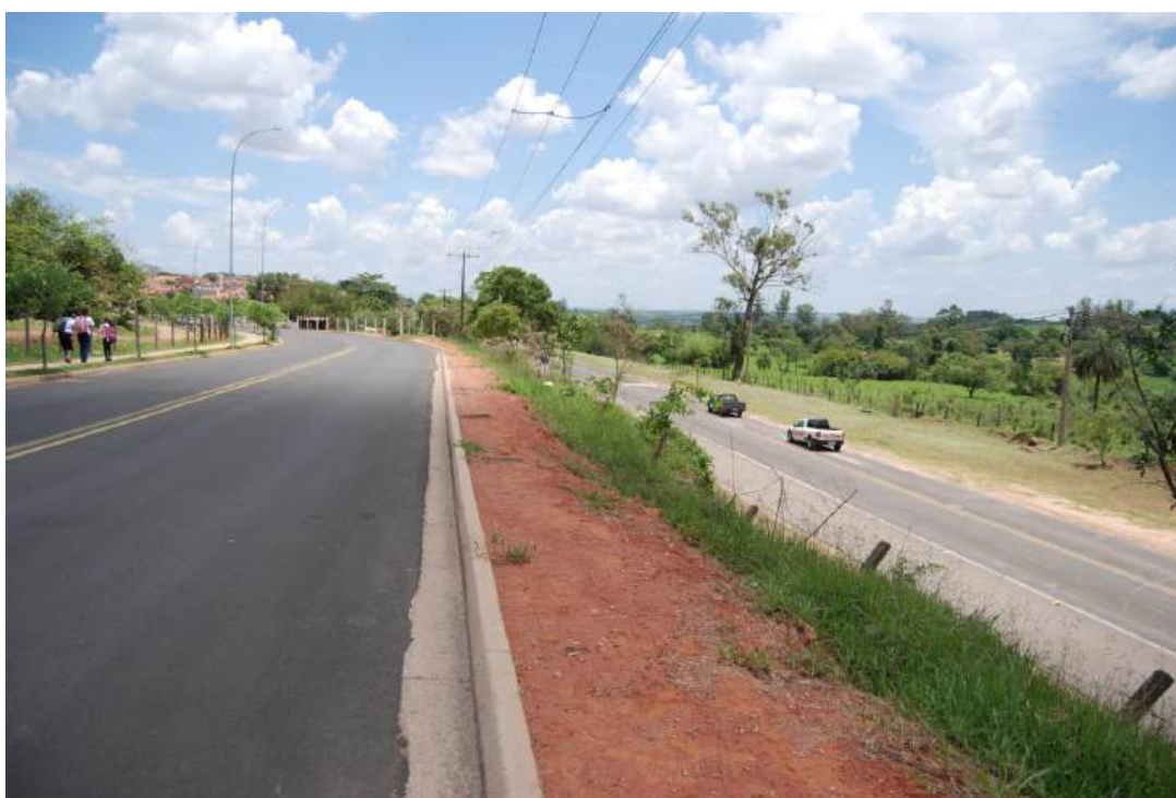
Foto 04 – Acesso ao empreendimento. Avenida Marginal. À direita a Estrada João Batista Merlin.
