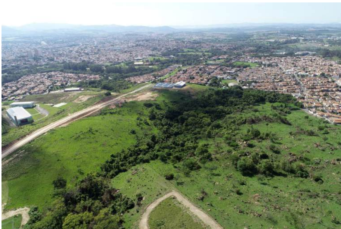
Foto 25 - Vista da área de entorno da gleba do empreendimento. A APP existente e o maciço arbóreo estão localizados fora da área do loteamento. Fonte. Tag Geo Engenharia.
