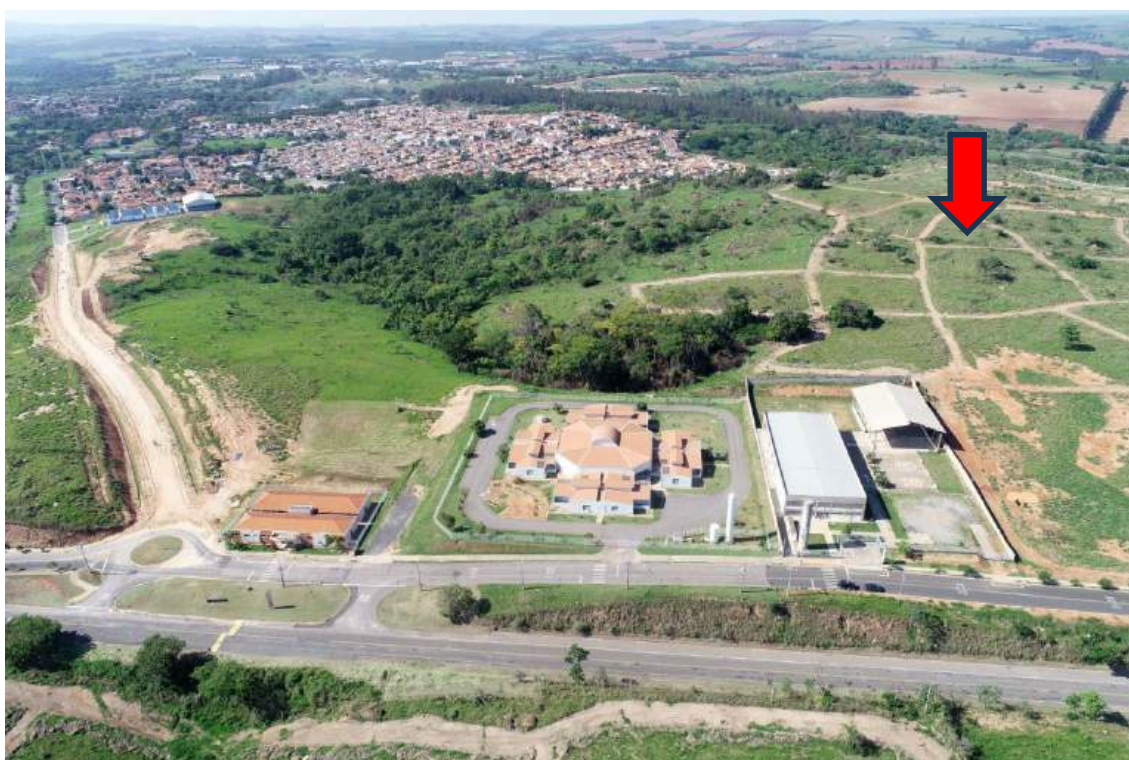
Foto 23 - Vista da área da gleba do empreendimento e sua AII, demonstrando o conjunto institucional formado pela EMEB Hélio Ornelas Borges, pela EMEB Profa. Adélia Jorge Adib Nagib, pela Unidade de Saúde Dr. Sebastião José Rodrigues. Pode-se ver o prolongamento da
