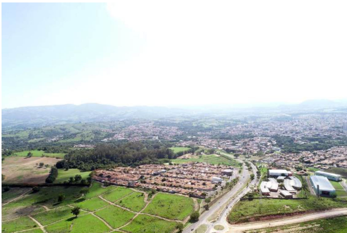
Foto 21 Vista da área de entorno do empreendimento mostrando o Maestro Mourão à esquerda ao lado da área onde será implantado o loteamento Guiomar Novaes. À direita o SESI e o Instituto Federal. Fonte: Tag Geo Engenharia.
