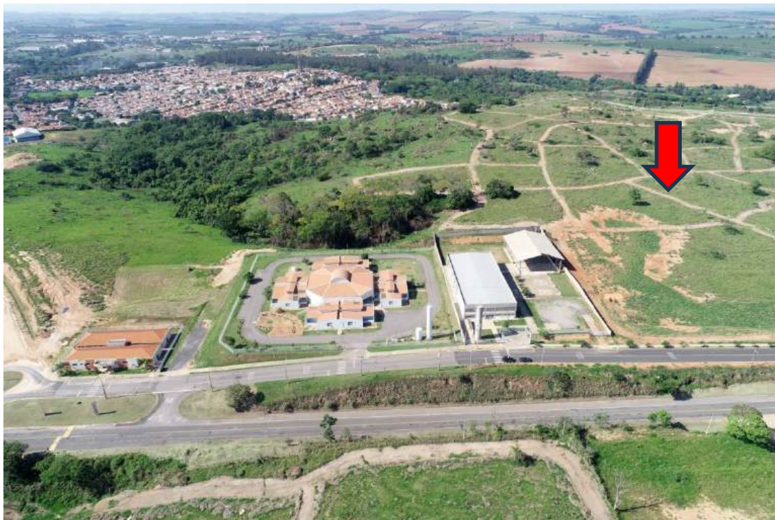
Foto 24 - Vista da área da gleba do empreendimento e sua All. Fonte. Tag Geo Engenharia.
