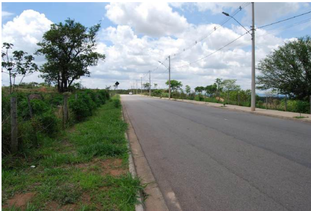
Foto 07 – Viário de acesso ao empreendimento, prolongamento da Rua Aparecido Candido.
