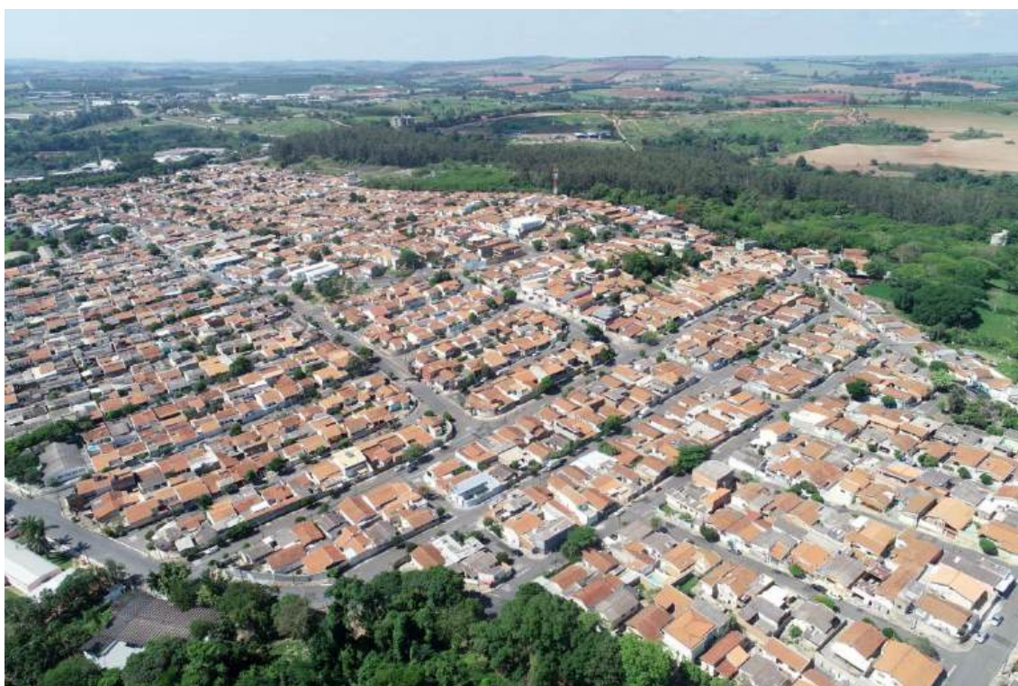
Foto 29 - Vista da área da área de entorno – Jardim Novo Horizonte, Núcleo Residencial Durval Nicolau I e II e Vila N.S de Fátima, Fonte. Tag Geo Engenharia.
